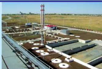
Городские коммунальные очистные сооружения.
